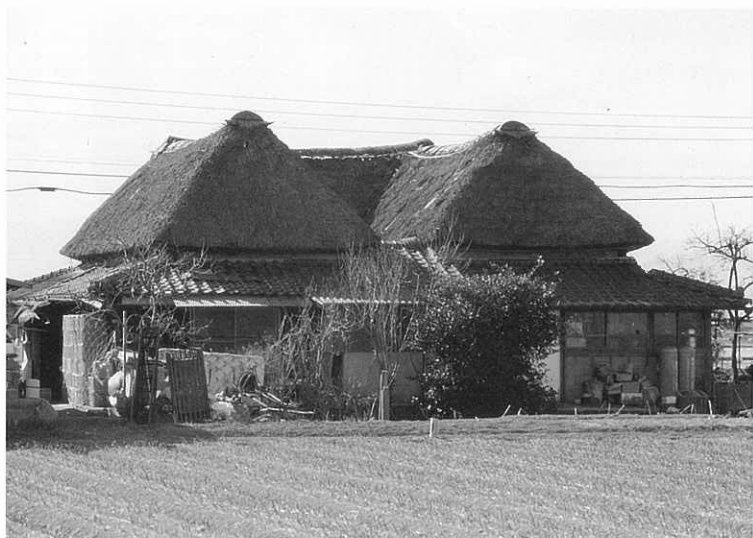
写真1 白石平野に建つ「クド造り」民家(佐賀県杵島郡白石町)
