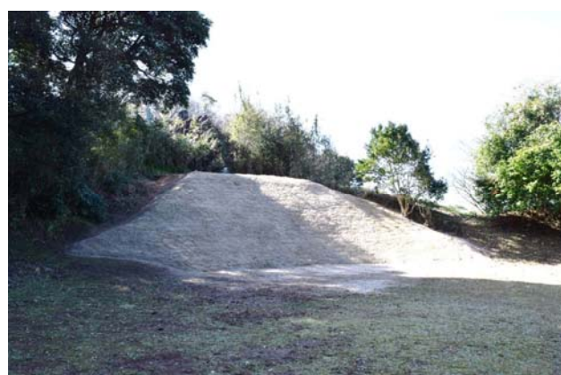
名護屋城跡 上山里丸修景整備工事(北東から)
