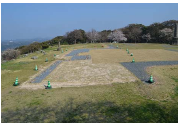
名護屋城跡 本丸御殿修景整備工事(南東から)
