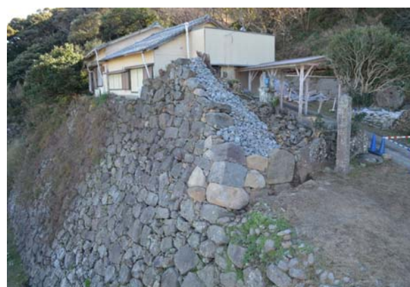
名護屋城跡 水手通路櫓台石垣修理工事(北東から)
