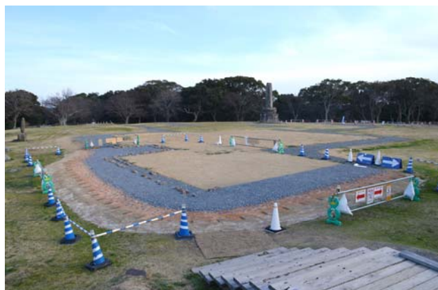
名護屋城跡 本丸御殿修景整備工事(北西から)
