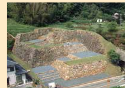
整備終了後の名護屋城跡山里口
