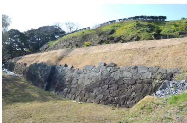
名護屋城跡本丸北裾法面保護工事(北西から)
