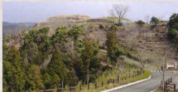
参考 佐敷城跡(国史跡・熊本県葦北郡葦北町)
